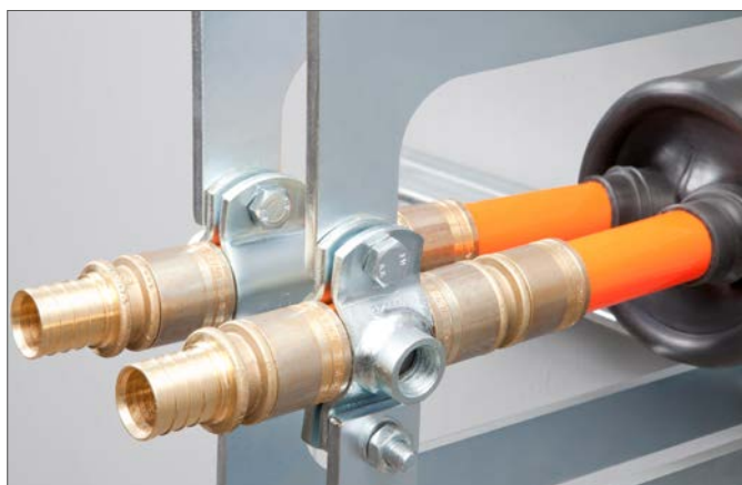
Abb. 6: Fixierung der Mediumrohre am Hausanschluss
